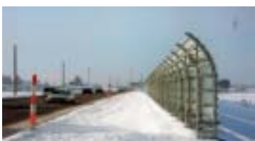
図3 設置された翼型誘導板を有する飛翔型防雪柵(北海道・東北に設置され、現在総延長約25kmに達している)
